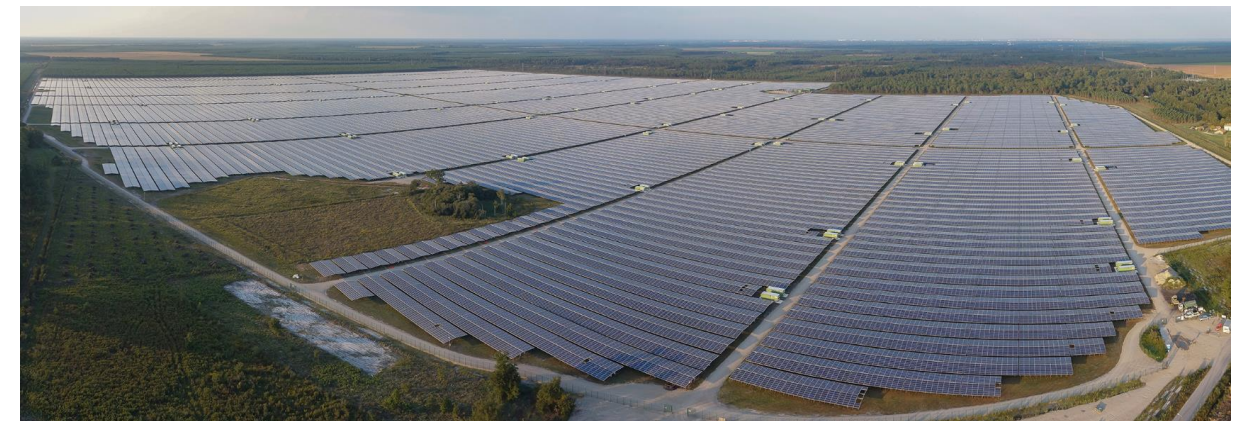
Figure 1 : Parc photovoltaïque de Cestas – septembre 2015 (source : NEOEN, 2017)
