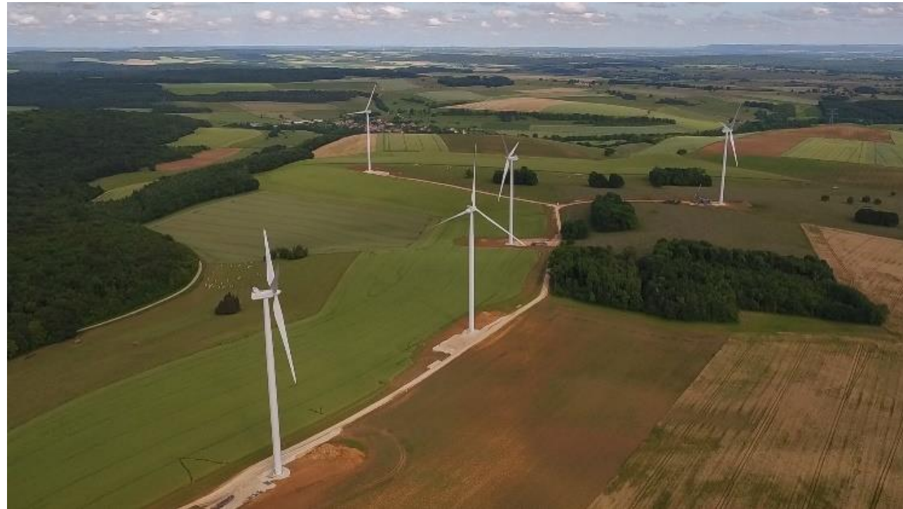
Figure 4 : Vue générale du parc éolien des trois communes (source : NEOEN, 2017)
