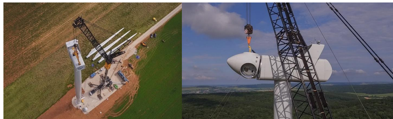
Figure 5 : De gauche à droite : Vue du montage de l'éolienne n°10 – Installation du moyeu sur l'éolienne n°6 (source : NEOEN, 2017)
